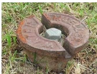
Sur le dernier avis, nous vous informions du nouveau règlement de tarification pour la fermeture des valves à eau. Il s'agit de la valve à eau extérieure, située sur la façade du terrain (telle que l'image ci-contre).
